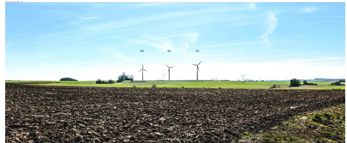
Montbrehain (02) – Projet éolien de 6,9MW autorisé et en préparation pour la construction
